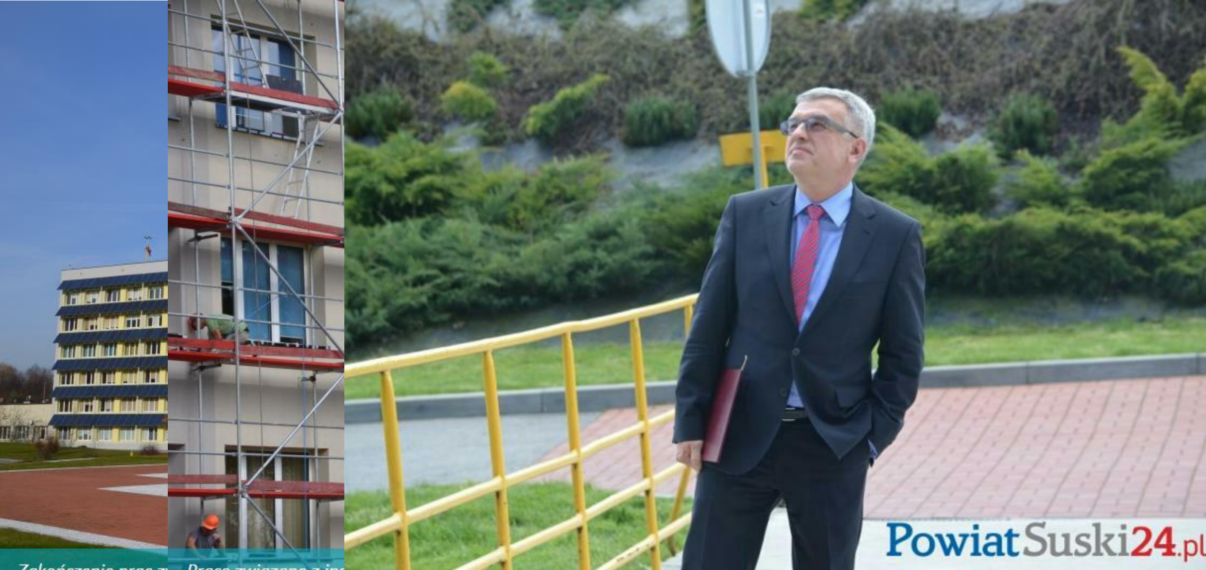
Zakończenie prac z... Prace związane z instalacją modułów fotowoltaicznych - 10.09. 2015 r.
